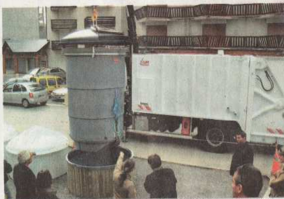
Installation d'un conteneur dans la station. Photo Alain Maillé.
